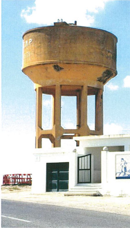
Foto 1 – Aspeto geral do reservatório
