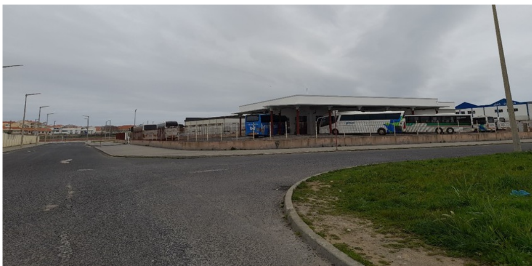
Figura 70. Enquadramento da Interface Rodoviária de Peniche.
