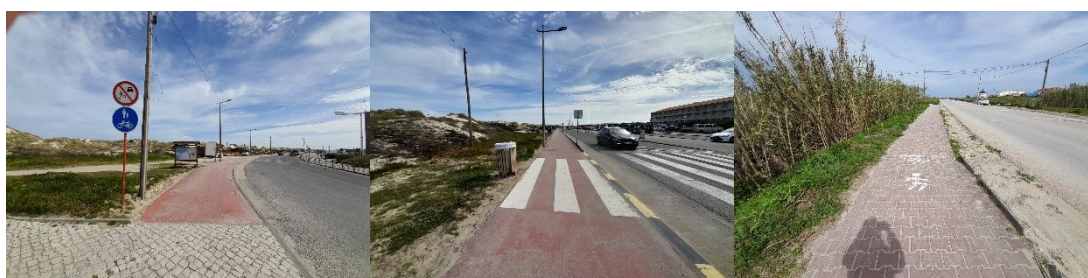
Figura 60. Ciclovia existente junto da Avenida da Praia
