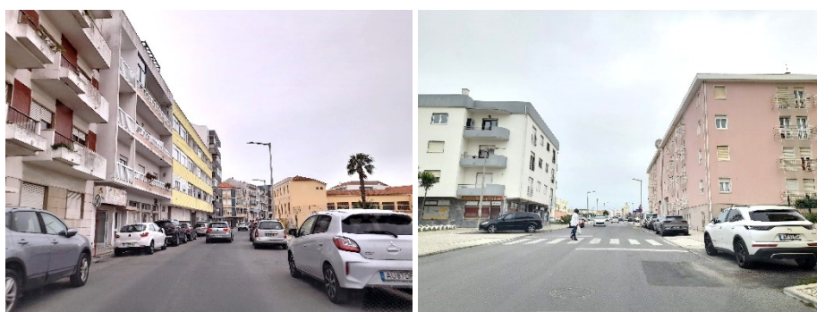
Figura 47. Debilidades da infraestrutura pedonal na Rua Estados Portugueses das Índia (Atouguia da Baleia) (esq.) e Rua Arquiteto Paulino Montez (Peniche) (dir.)
