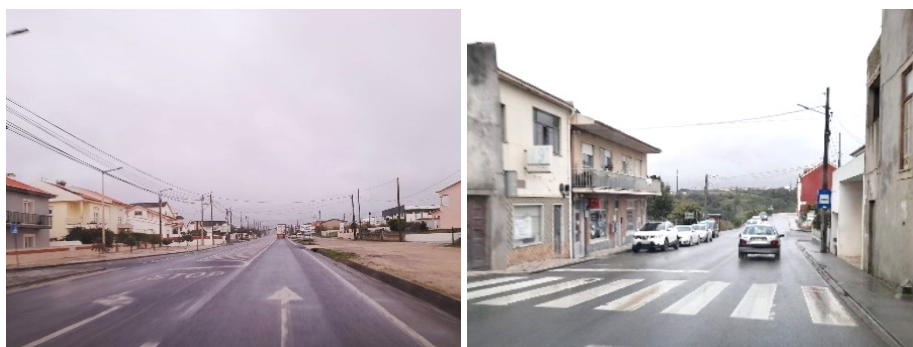
Figura 49. Debilidades da infraestrutura pedonal na N114 (Atouguia da Baleia)
