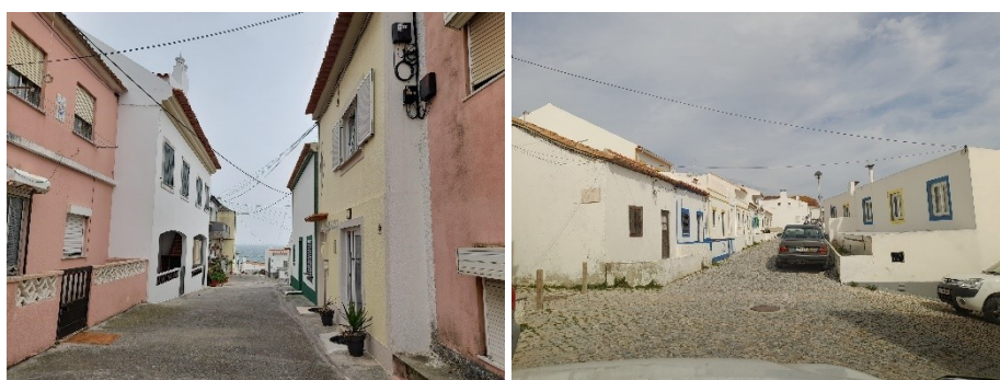
Figura 48. Debilidades da infraestrutura pedonal na Rua das Ondas (Peniche) (esq.) e Rua Dr. José Formosinho Sanches (Ferrel) (dir.)
