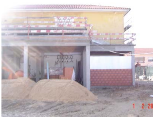
Execução da estrutura na ampliação da escola
