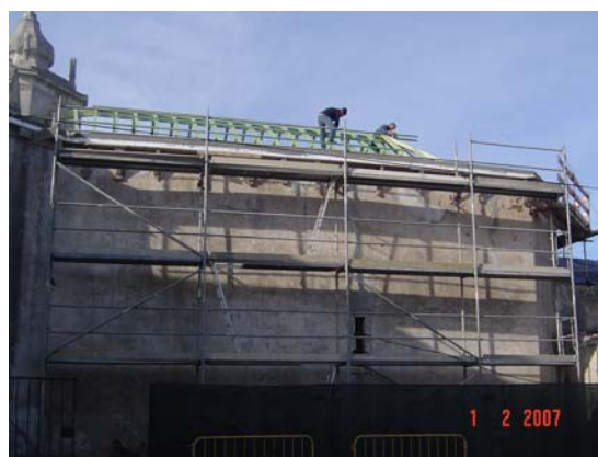
Estrutura da cobertura da Igreja
