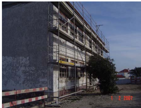
Construção da cobertura do edifício da escola.
