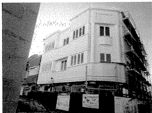
Fotografia 1 – Vista do alçado principal
