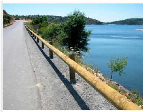
Figura 6 | Rail de proteção em madeira com 2.0m entre prumos
