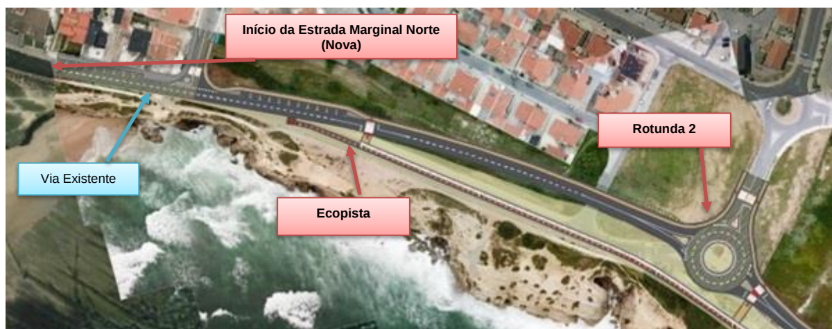
Figura 2 | Trecho inicial da Estrada Marginal Norte e compatibilização com o existente
