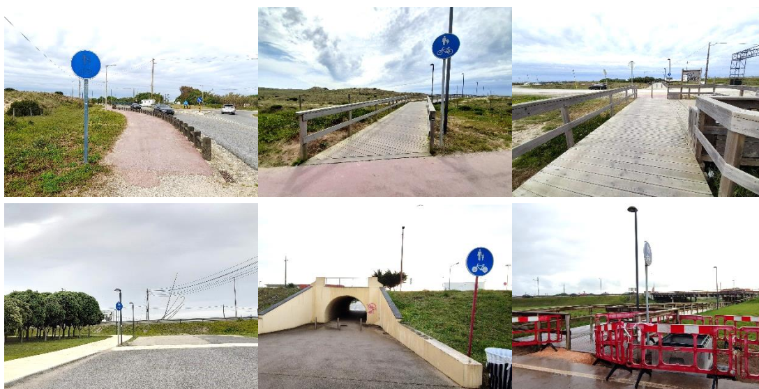
Figura 62. Ciclovia existente na proximidade do Estádio do Grupo Desportivo de Peniche
