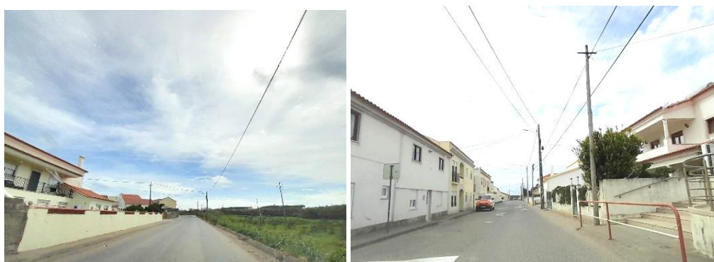
Figura 53. Debilidades da infraestrutura pedonal na Rua Padre Santo António (Ferrel) (esq.) e Rua da Carreira (Atouguia da Baleia) (dir.)
