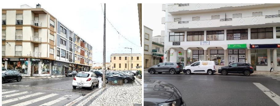
Figura 49. Debilidades da infraestrutura pedonal na Rua Primeiro de Dezembro (Peniche) (esq.) e Largo Bispo de Mariana (Peniche) (dir.)
