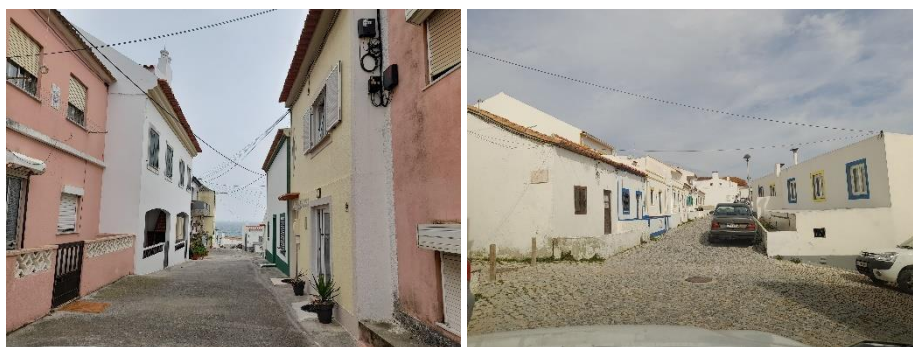
Figura 51. Debilidades da infraestrutura pedonal na Rua das Ondas (Peniche) (esq.) e Rua Dr. José Formosinho Sanches (Ferrel) (dir.)
