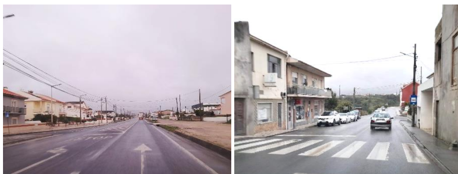
Figura 52. Debilidades da infraestrutura pedonal na N114 (Atouguia da Baleia)
