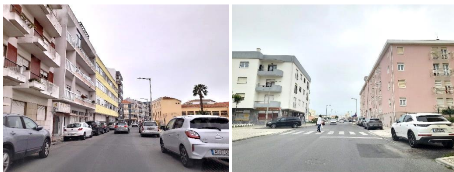
Figura 50. Debilidades da infraestrutura pedonal na Rua Estados Portugueses das Índia (Atouguia da Baleia) (esq.) e Rua Arquiteto Paulino Montez (Peniche) (dir.)
