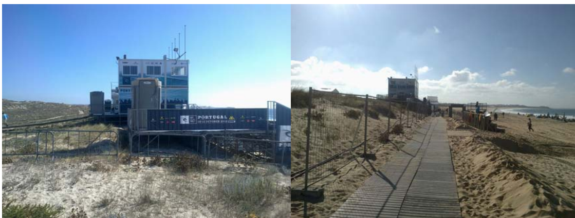
Fotografias 1 e 2 – Estruturas de apoio no spot e vedação metálica e passadiço junto ao cordão dunar
