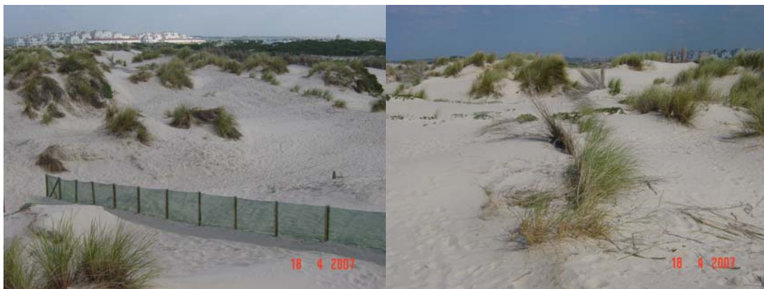
Fotografias 5 e 6 – Sistema de retenção de areia e crescimento natural de vegetação autóctone no sistema dunar norte
