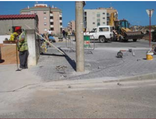
Construção de passeios na Rua do Fialho
