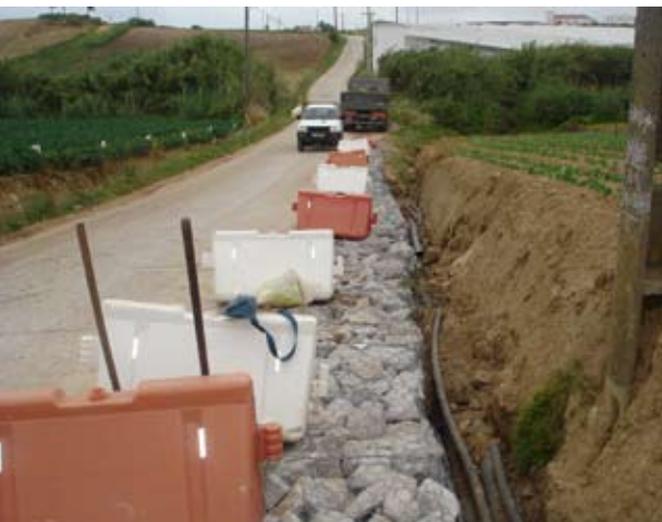
Colocação de gabiões na estrada de ligação entre a Atouguia da Baleia e Lugar da Estrada
