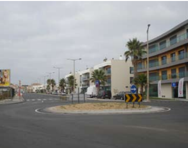
Construção da Rotunda do Porto de pesca
