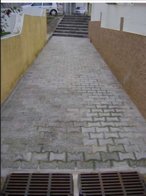
Obra de saneamento na Rua de Baixo, Lugar da Estrada, Atouguia da Baleia
