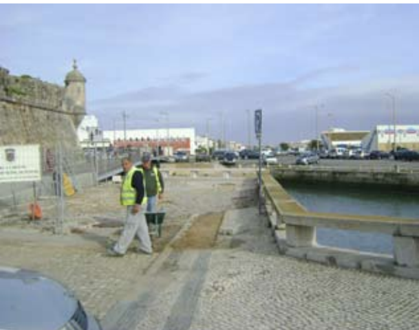
Estacionamento adjacente CMP
