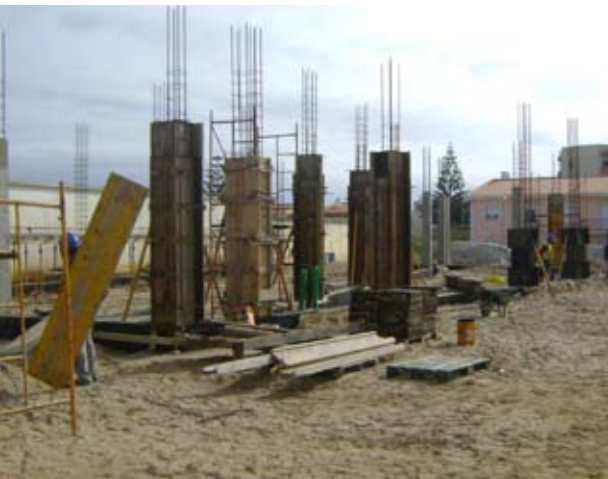
Construção Casa Mortuária
