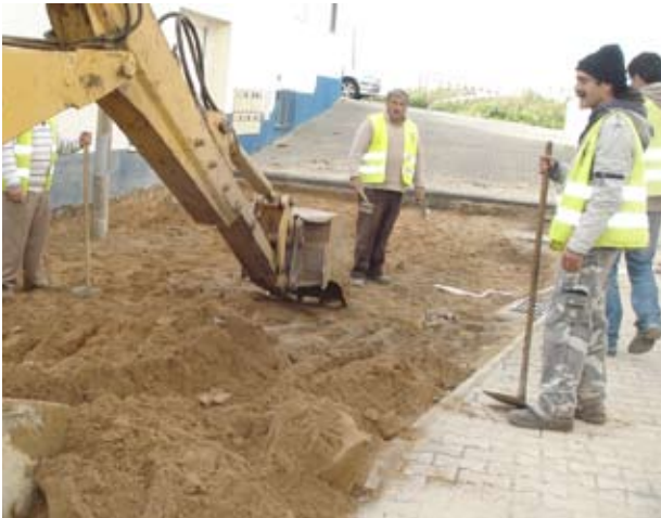
Intervenção na Praceta de São Pedro Telmo
