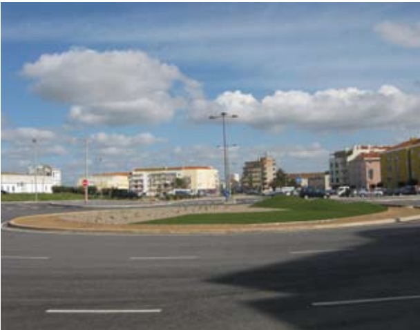
Construção da Rotunda Avenida Paulo VI
